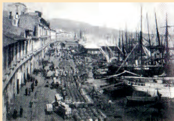
Город до землетрясения: суета в порту
