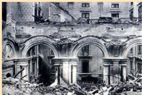
Здание почты после землетрясения
